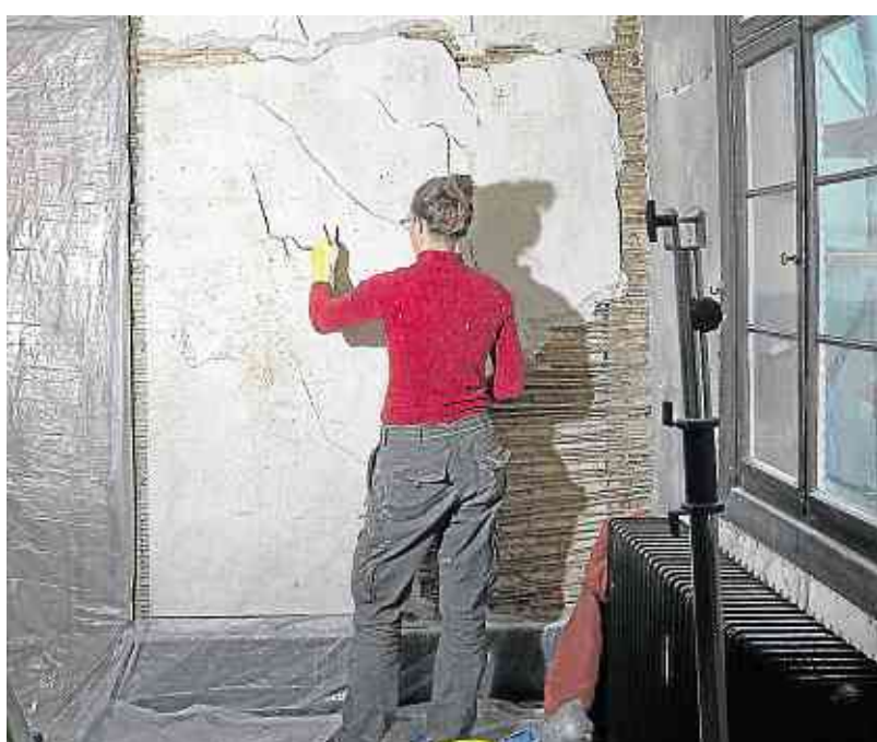
Die Wände werden aufwendig bearbeitet, damit die Tapeten später passen.
